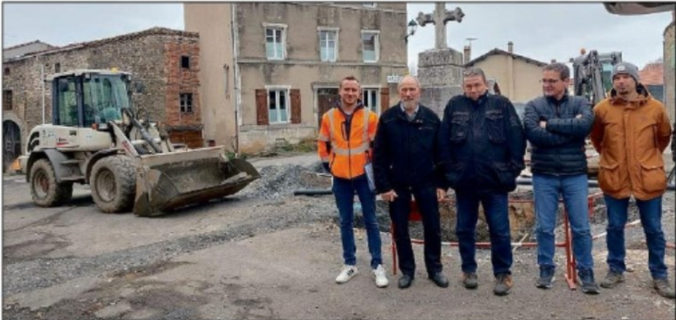
ISSERTEAUX. La commune a bénéficié de renouvellement de son réseau d’eau.
